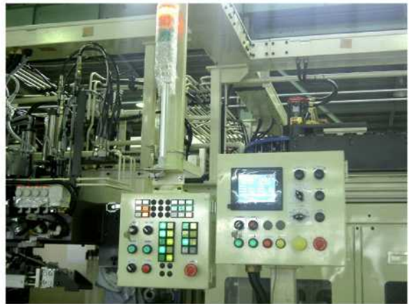
コンベヤー、機械操作盤
