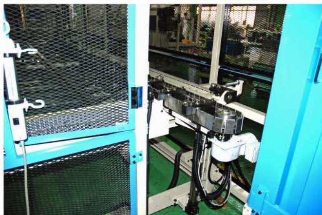
同左—レール搬入コンベヤー
