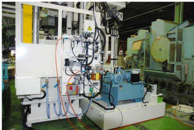
空圧、潤滑、油圧ユニット
