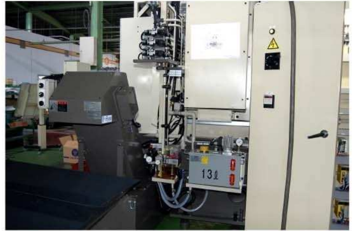
チップコンベヤー、潤滑装置
