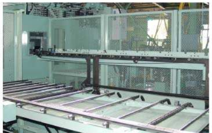
▲レール受けだし装置及び搬出ストッカー
