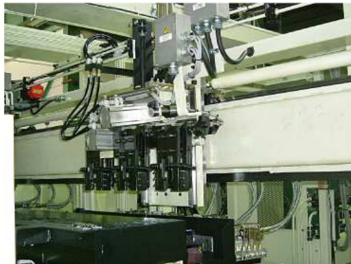
▲中央部に設けられた上部搬送型ローダー
