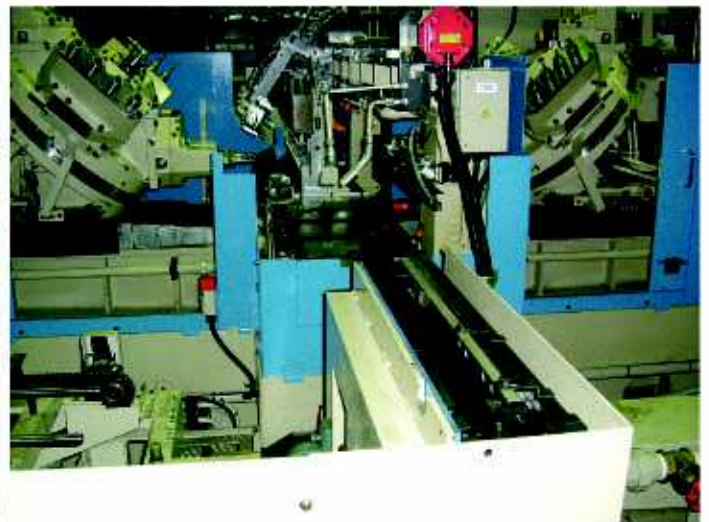
▲レール搬出受け出し部分
